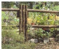
Otro cerco de postes finos de eucalipto , tratados con pintura asfáltica, que lo vuelven más resistente a la intemperie.
