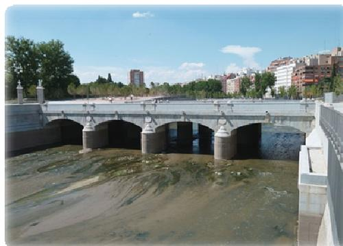
Dentro del puente pueden observarse dos lados; el septentrional es el más antiguo y el meridional el más moderno (ampliación del puente por la II República).
